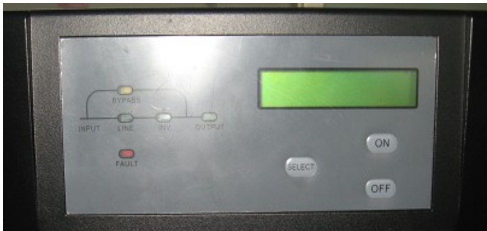
Рис. 3.3-1 Внешний вид лицевой панели Monolith K 6000LT
